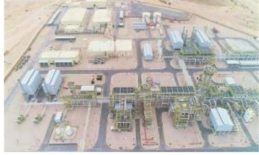
وتبلغ طاقة المصنع من معالجة الغاز حوالي ٨ ملايين متر مكعب قياسي في اليوم من الغاز الخفيف، وسينتج حوالي ٣٠٤ كيلو أطنان سنوياً من منتجات الغاز البترولي المسال المكونة من
